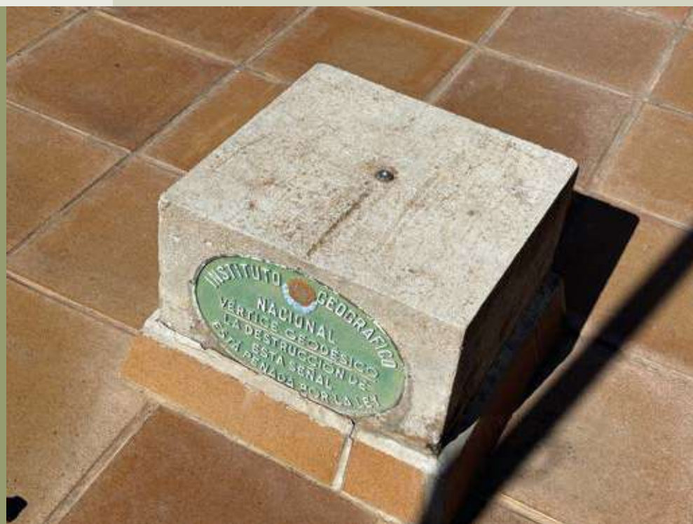
Vèrtex geodèsic a la coberta de la torre.
