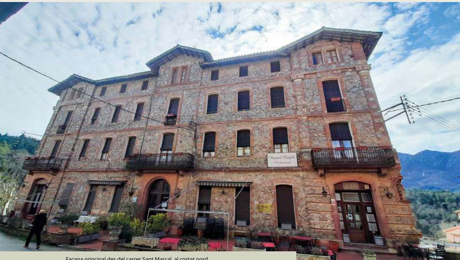
Façana principal des del carrer Sant Marçal, al costat nord.
